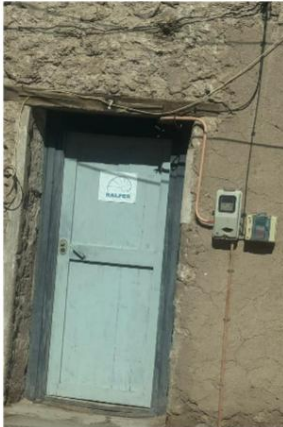
INSPECCIÓN DE AUTOMÁTICOS
