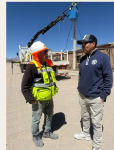
AVANCE NORMALICACION TENDIDO ELECTRICO
