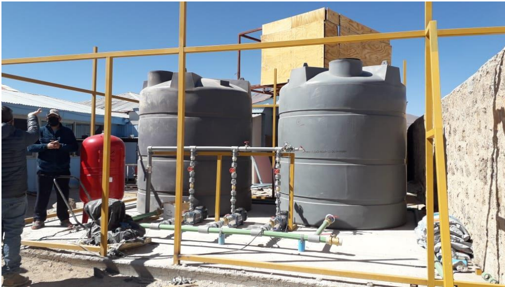
Proy. Construcción Plazoletas Interactivas en etapa Obra gruesa
